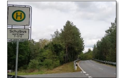
Bushaltestellen an der Straße oder mit Einbuchtung
